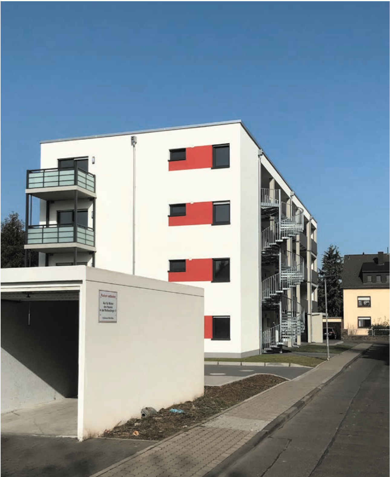
In der Wehring: Neubau
