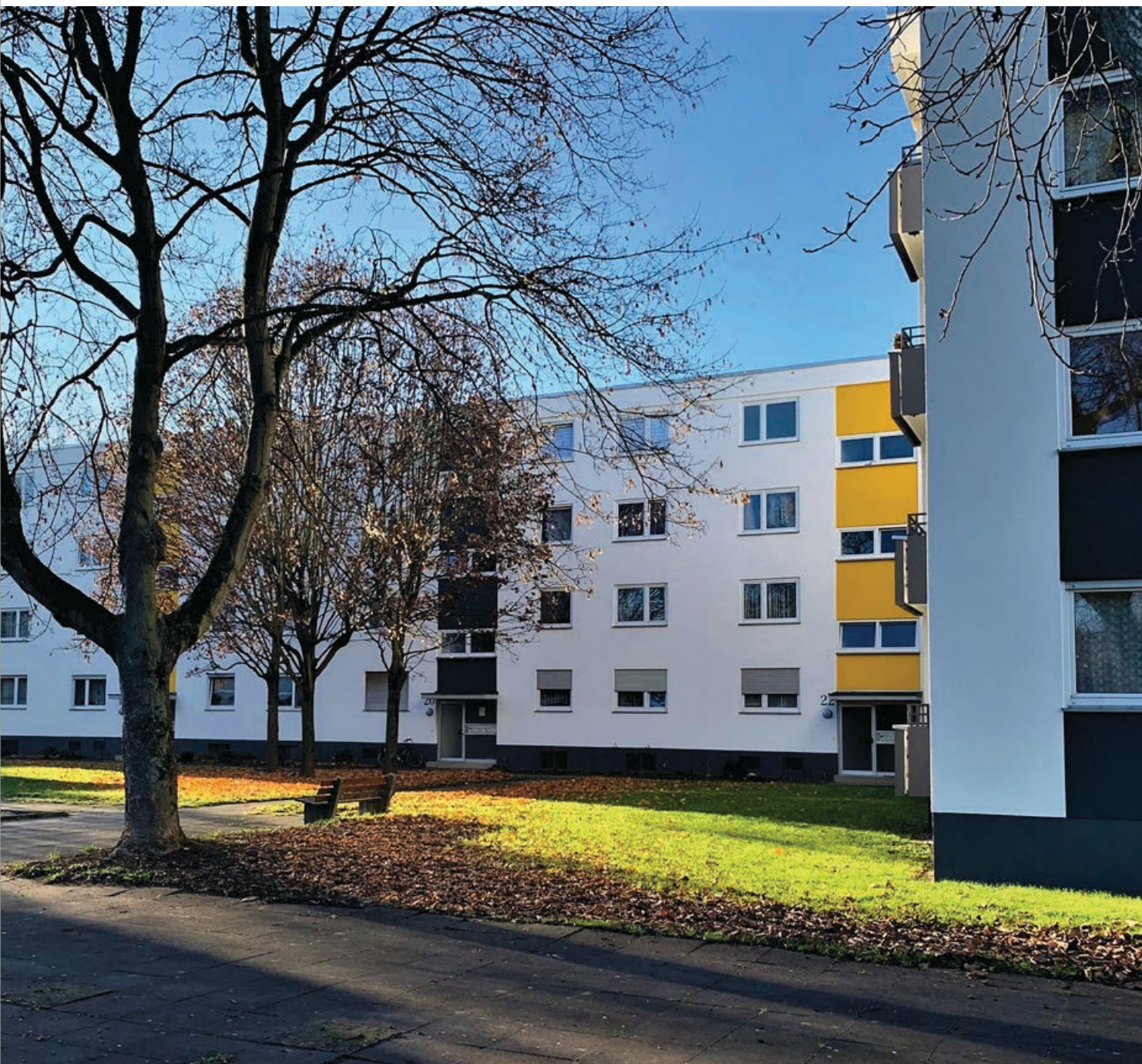
Sanierung Fritz-Michel-Straße 16–22 und 26, Koblenz-Neuendorf
