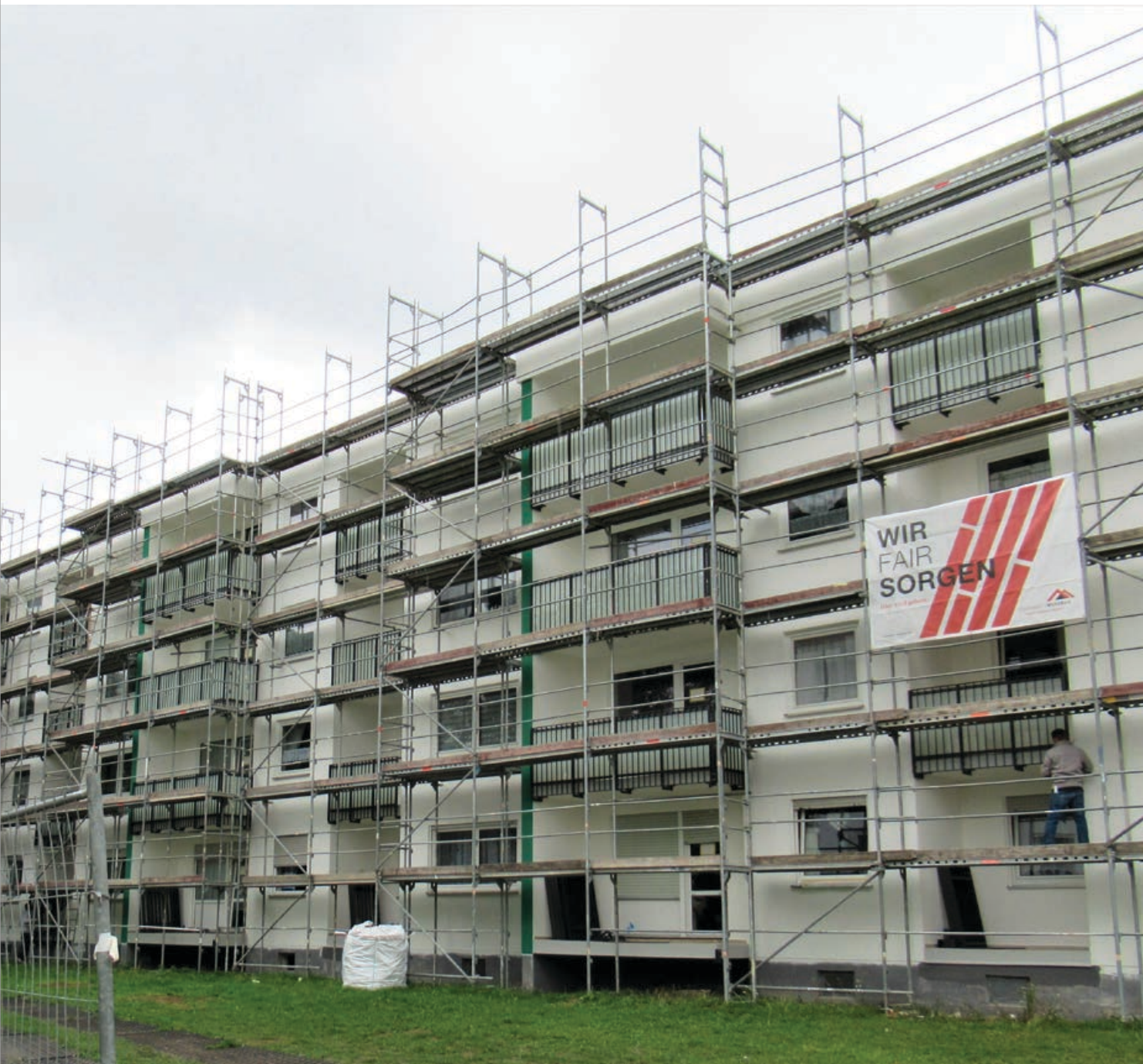
Sanierung Fritz-Michel-Straße, Koblenz-Neuendorf
