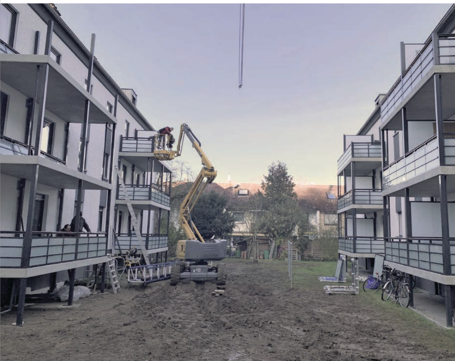
Balkonanbau Foelixstraße 15 und 17, Goldgrube
